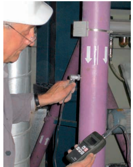
Wandstärkenmessung mit Ultraschallgerät
